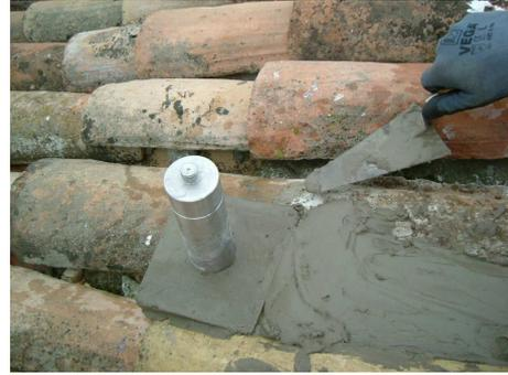
**foto 13** – Dopo avere gettato il micropilastrino ho raccordato uno scivolo in cemento per lo scolo dell'acqua
