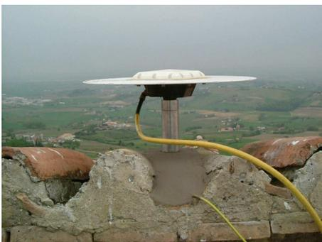
**foto 16** – Installazione e allacciamento antenna geodetica
