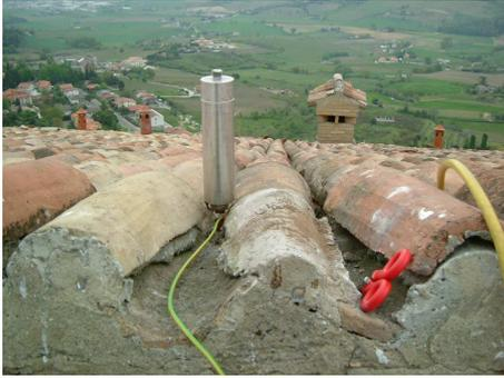
**foto12** – Il vertice resinato in profondità e collegato alla rete di terra
